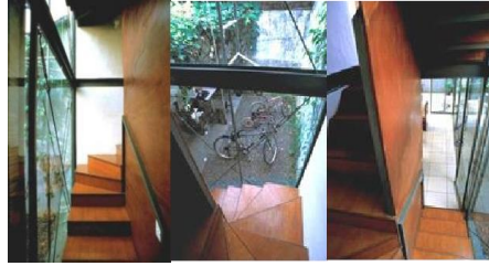
Gambar 17. Lebar fungsional tangga 65 cm, kurang optimal, khususnya bila bersamaan dengan pemindahan barang (Sumber: Penulis, 2022)
