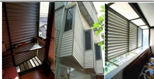
Gambar 10. Jendela tidak menghadap depan (jalan) melainkan timur, sehingga panas & silau matahari antara jam 10:30 – 12:00 cukup leluasa. Lubang ventilasi di kamar anak ada di bawah jendela miring keluar.
