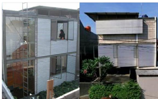
Gambar 9. Dinding luar, didominasi material lembaran metal gelombang dan bata putih yang digunakan tanpa lapisan lain dan kaca bening di bagian tangga (Sumber: Penulis, 2022)
