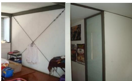
Gambar 8. Dinding sebagai pembatas di ruang dalam plywood 6 mm dengan rangka besi 4x4 cm, dilapis cat tembok
