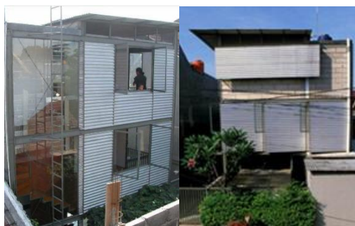
Gambar 9. Dinding luar, didominasi material lembaran metal gelombang dan bata putih yang digunakan tanpa lapisan lain dan kaca bening di bagian tangga
