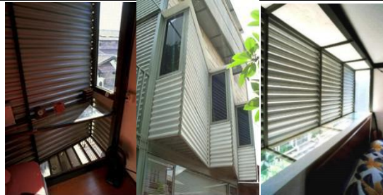
Gambar 10. Jendela tidak menghadap depan (jalan) melainkan timur, sehingga panas & silau matahari antara jam 10:30 – 12:00 cukup leluasa. Lubang ventilasi di kamar anak ada di bawah jendela miring keluar (Sumber: Penulis, 2022)
