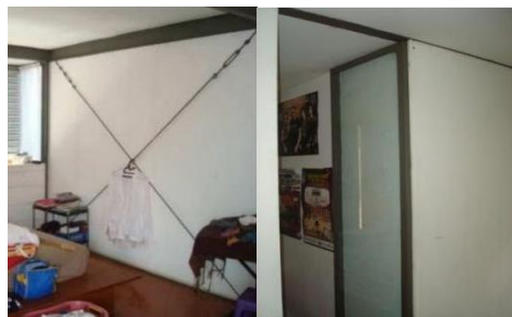
Gambar 8. Dinding sebagai pembatas di ruang dalam plywood 6 mm dengan rangka besi 4x4 cm, dilapis cat tembok (Sumber: Penulis, 2022)
