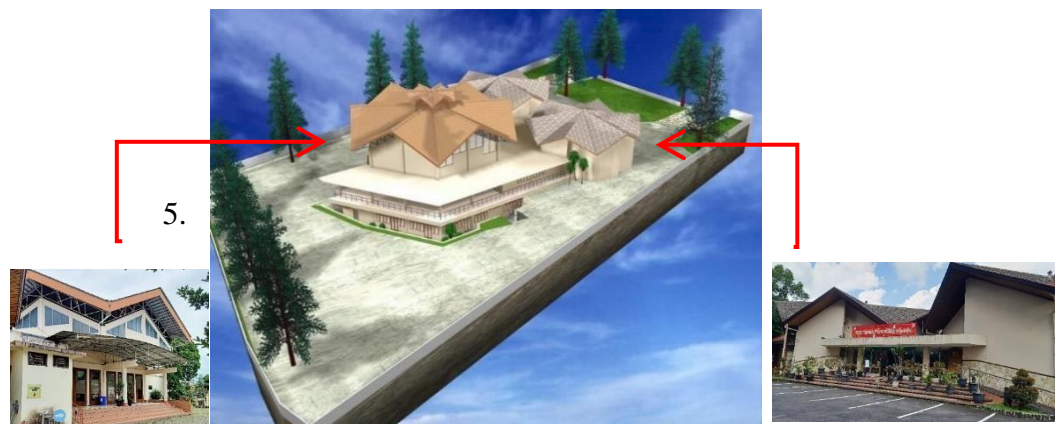
Gambar 5. Kondisi bangunan GKJ Salatiga (Sumber dokumen pembangunan gereja 2006 & dokumentasi penulis 2022)
