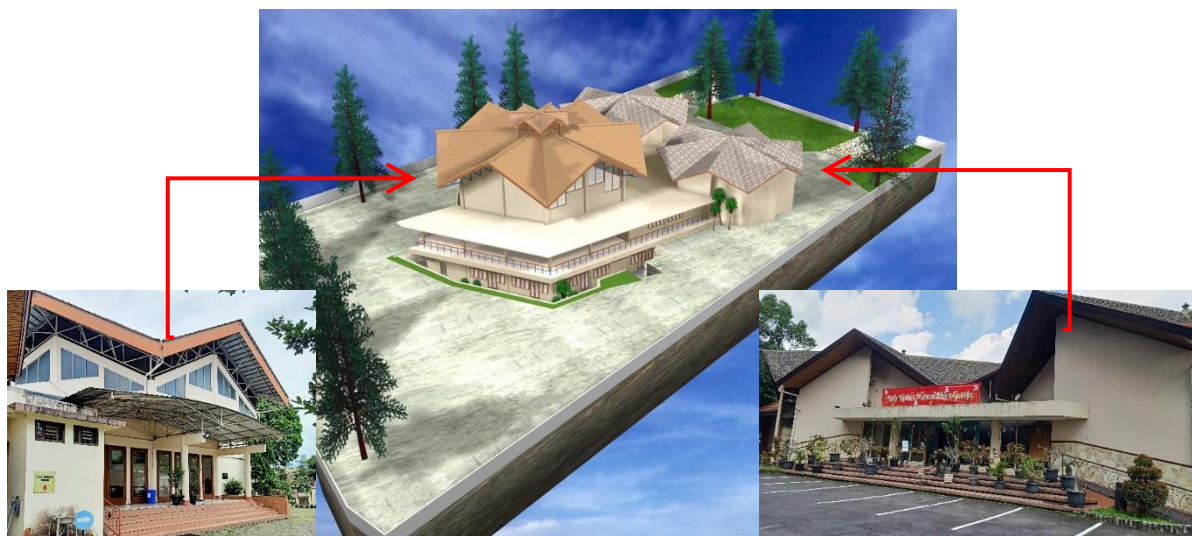
Gambar 1 Kondisi bangunan GKJ Salatiga (Sumber dokumen pembangunan gereja 2006 & dokumentasi penulis 2022)
