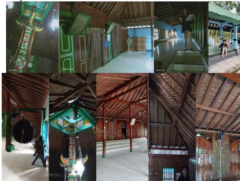
Gambar 4. Foto atap, dinding, Lantai & plafon (Sumber: Dokumentasi pribadi, 2022)
