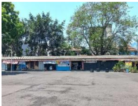
Gambar 19. Kios - Kios Terminal Landungsari 2 (Sumber: dokumentasi pribadi, 2024)
