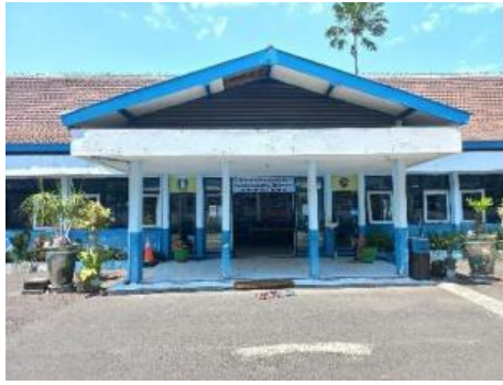
Gambar 11. Kantor Penyelenggara Terminal Landungsari 1 (Sumber: dokumentasi pribadi, 2024)
