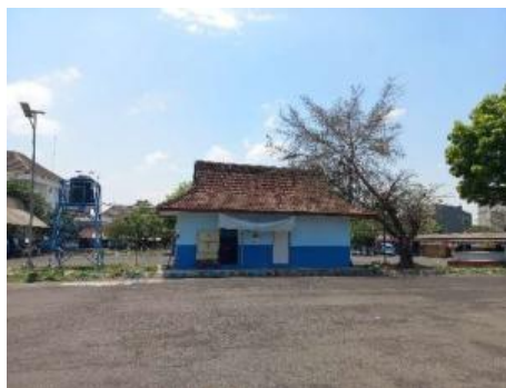
Gambar 16. Toilet Awak Kendaraan Terminal Landungsari
