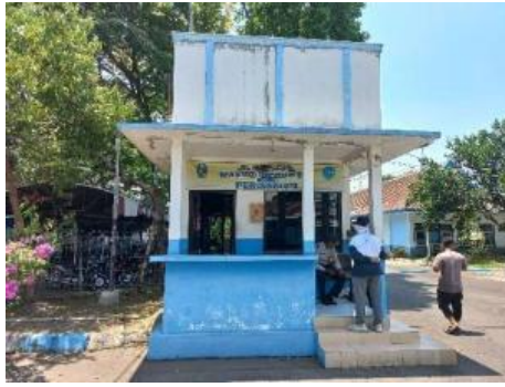
Gambar 17. Toilet Awak Kendaraan Terminal Landungsari (Sumber: dokumentasi pribadi, 2024)
