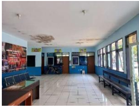
Gambar 12. Kantor Penyelenggara Terminal Landungsari 2 (Sumber: dokumentasi pribadi, 2024)
