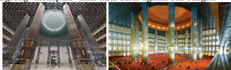
Gambar 4. 12 tiang penyangga kubah
