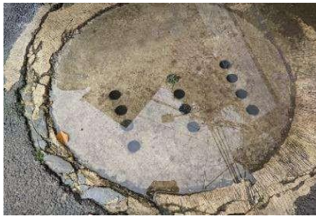
Gambar 8. Sumur Resapan Air Hujan
