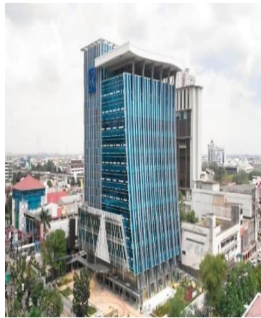
Gambar 2. Gedung Menara BRI Sumber: Google, 2026
