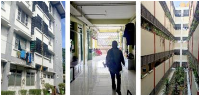
Gambar 5. Ventilasi belakang, ventilasi koridor, dan void pada rusunawa
