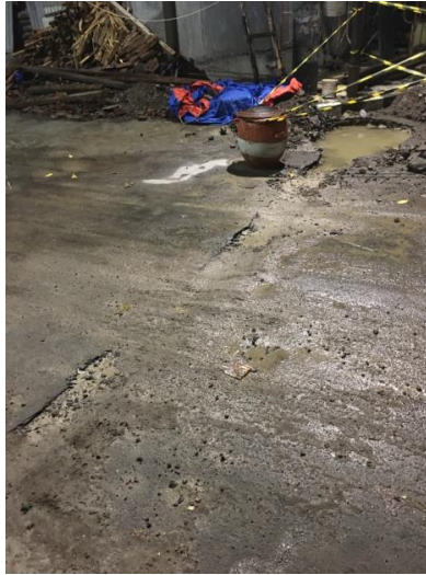
Gambar 4. Penyambungan pipa PDAM ke meteran air Sumber: Tim pengabdian, 2023
