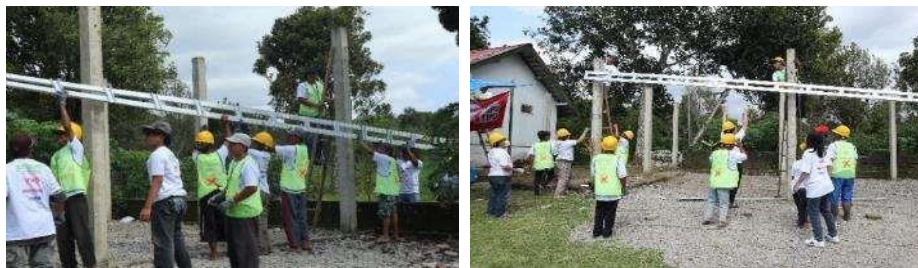
Gambar 15. Pemasangan Balok Regel
