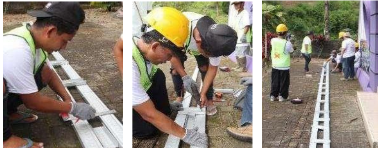
Gambar 13. Perakitan Balok Regel Baja Ringan
