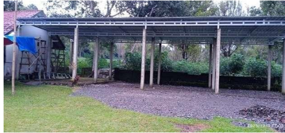
Gambar 18. Atap Baja Ringan Ruang Komunal
