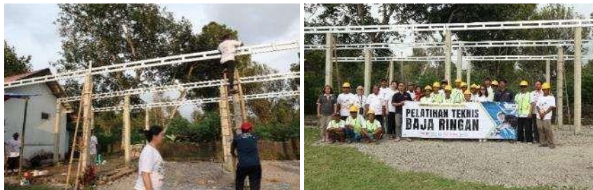
Gambar 17. Merakit Balok Regel
