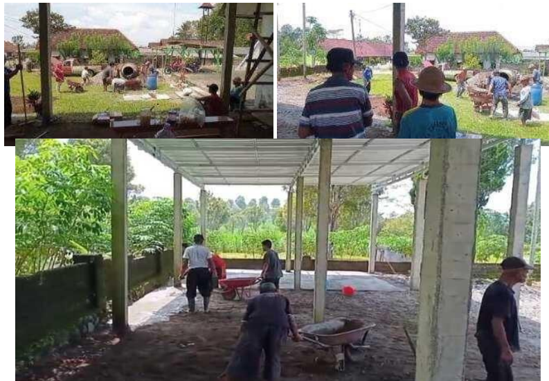
Gambar 21. Gotong Royong Merabat Lantai Ruang
