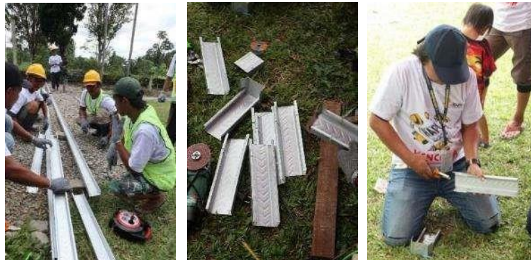
Gambar 14. Pembuatan Balok Gording dan Angkur
