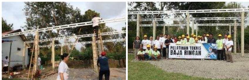
Gambar 17. Merakit Balok Regel
