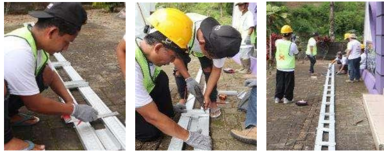
Gambar 13. Perakitan Balok Regel Baja Ringan
