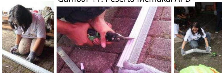
Gambar 12. Pengukuran dan Pengguntingan Baja Ringan
