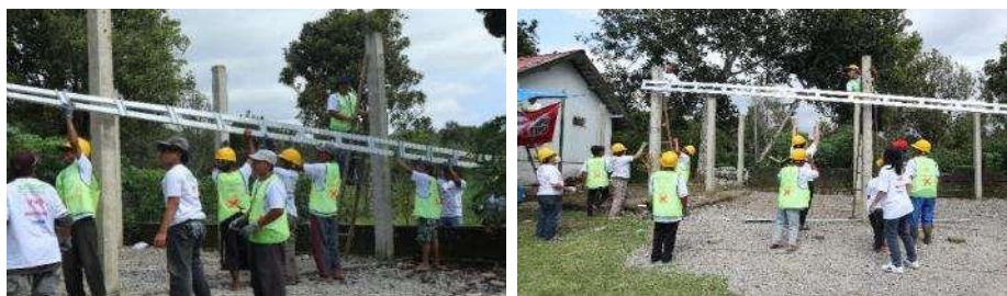
Gambar 15. Pemasangan Balok Regel
