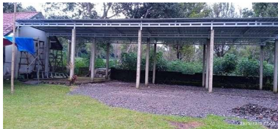
Gambar 18. Atap Baja Ringan Ruang Komunal
