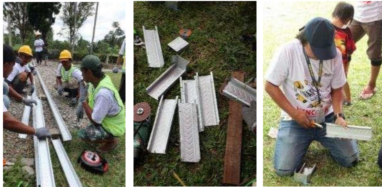
Gambar 14. Pembuatan Balok Gording dan Angkur
