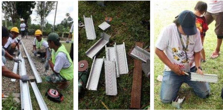
Gambar 14. Pembuatan Balok Gording dan Angkur
