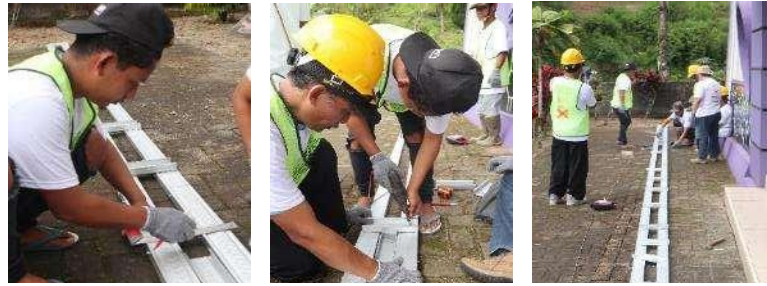
Gambar 13. Perakitan Balok Regel Baja Ringan
