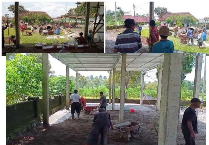
Gambar 21. Gotong Royong Merabat Lantai Ruang
