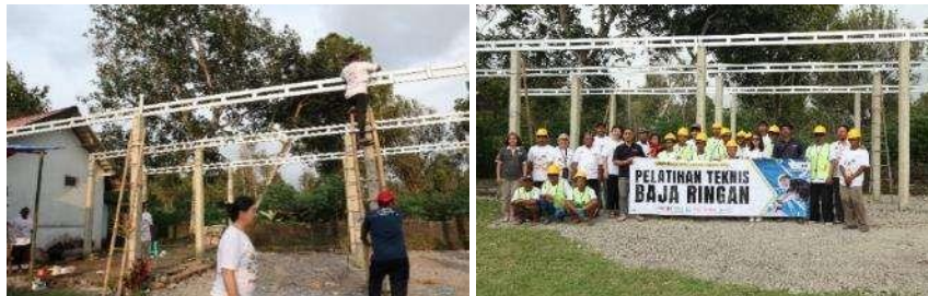
Gambar 17. Merakit Balok Regel
