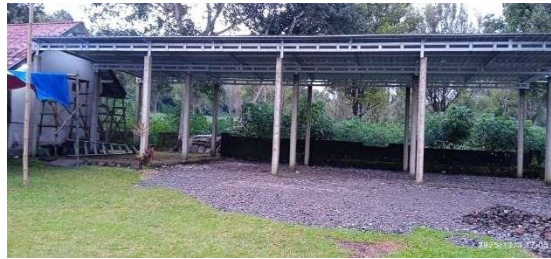
Gambar 18. Atap Baja Ringan Ruang Komunal
