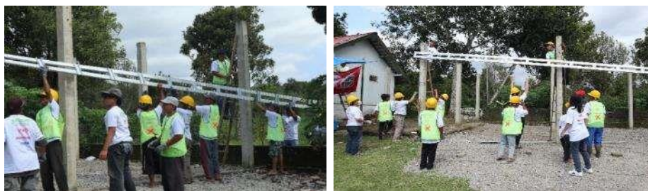
Gambar 15. Pemasangan Balok Regel
