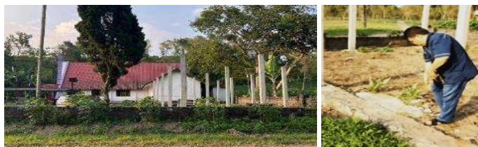
Gambar 3. Kondisi Eksisting dan Pengukuran
